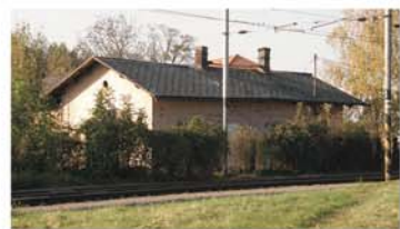
Původní budova nádraží v Předměřicích nad Labem, kde působil Michal Mácha. Byla zhořena v roce 2015. Foto: Bohuslav Škoda
